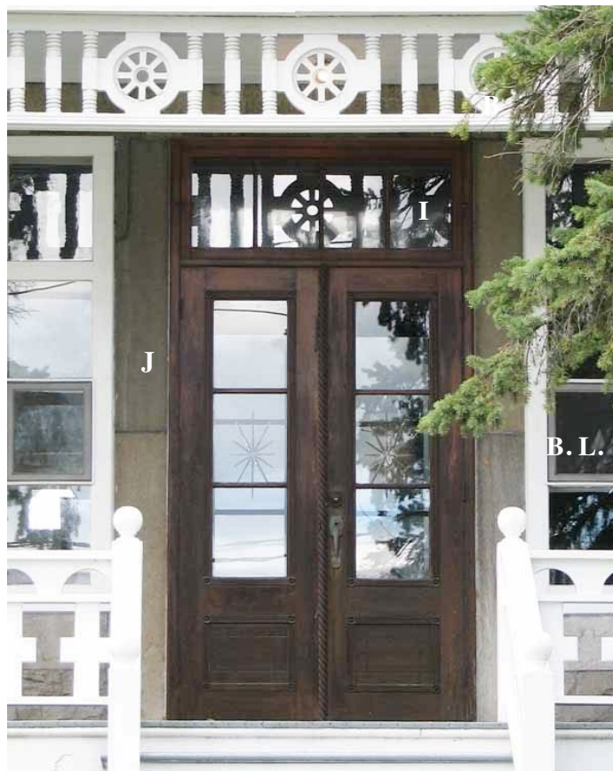
Portail à double battant en bois avec imposte (I) et baies latérales (B. L.), le tout encadré par des jambages (J) de pierre calcaire. Presbytère de Sainte-Anne. IMG_0191.jpg
