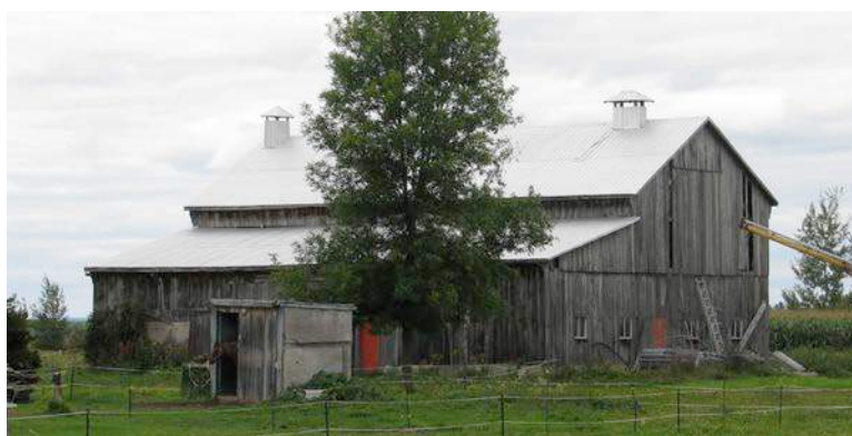
Grange-étable au toit à deux versants, avec appentis, recouverte de planches verticales au 473, rang Lepage. IMG_0624.jpg
