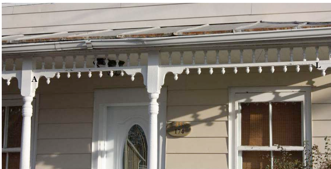
Au 174, rue Saint-Édouard, la galerie à colonnes tournées, ornées d'un lambrequin (L) à fuseaux et d'aiseliers découpés (A), contribue à donner un cachet patrimonial à l'édifice, tout comme les fenêtres à guillotine à grands carreaux. IMG_8805.jpg
