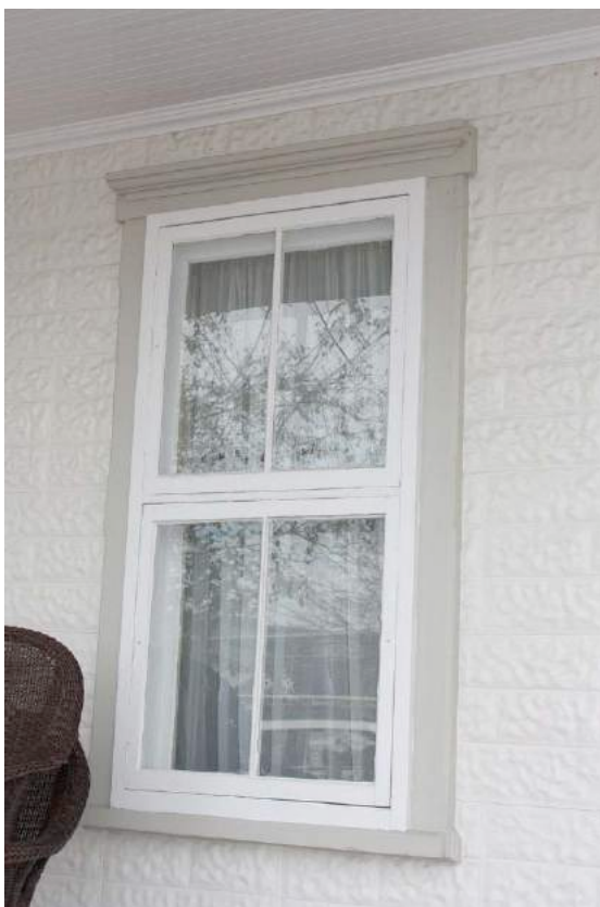
Fenêtre à guillotine à grands carreaux, extrêmement bien conservée, au 228, 3 e Avenue. IMG_8637.jpg
