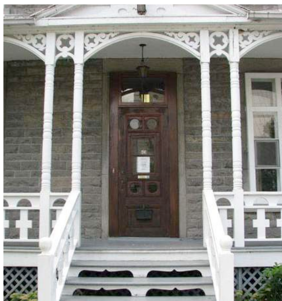
Contre-porte probablement d'origine. On remarquera les colonnes tournées et, à leur sommet, les aisseliers découpés à jour. Le garde-corps à motifs découpés en forme de croix a été remis en place après 1986. IMG_0194.jpg
