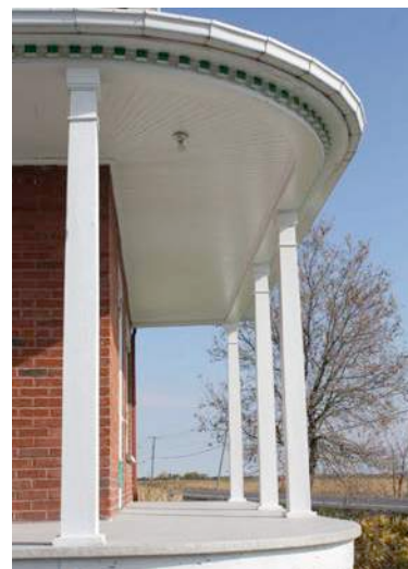
Intérieur du toit de la galerie constitué de planches emboutées. 93, rang du Trait-Carré. IMG_8268.jpg
