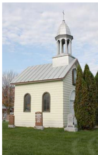
Mur gouttereau ouest et façade de la chapelle du cimetière. IMG_8360.jpg
