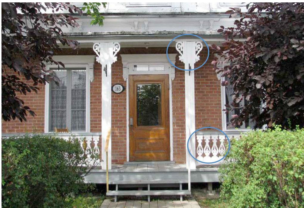
Garde-corps en bois à motifs découpés, aisseliers surmontant les colonnes et corniches à consoles caractérisent la façade avant de la maison des Prêtres-Chaumont
