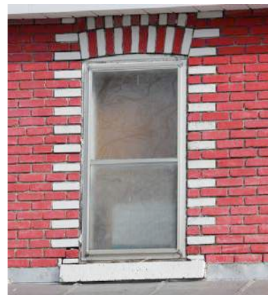
Arc surbaissé en brique rehaussé par des briques en relief. 245, 5 e Avenue. IMG_8992.jpg
