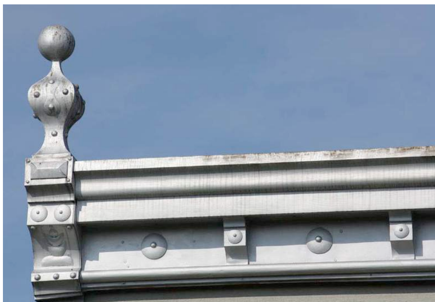
Corniche à modillons recouverte de métal. La console de l'extrémité supporte un vase à boule, aussi appelé amortissement. 91, rang du Trait-Carré. IMG_8280.jpg
