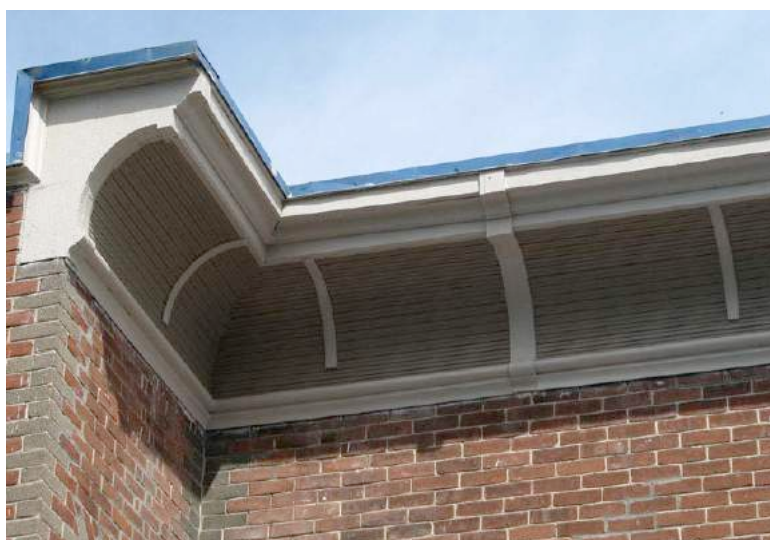
Corniche concave, semblable à celle ci-dessus. Elle est cependant en lattes de bois, un modèle plutôt rare à Sainte-Anne-des-Plaines. 163, boulevard Sainte-Anne. IMG_0323.jpg
