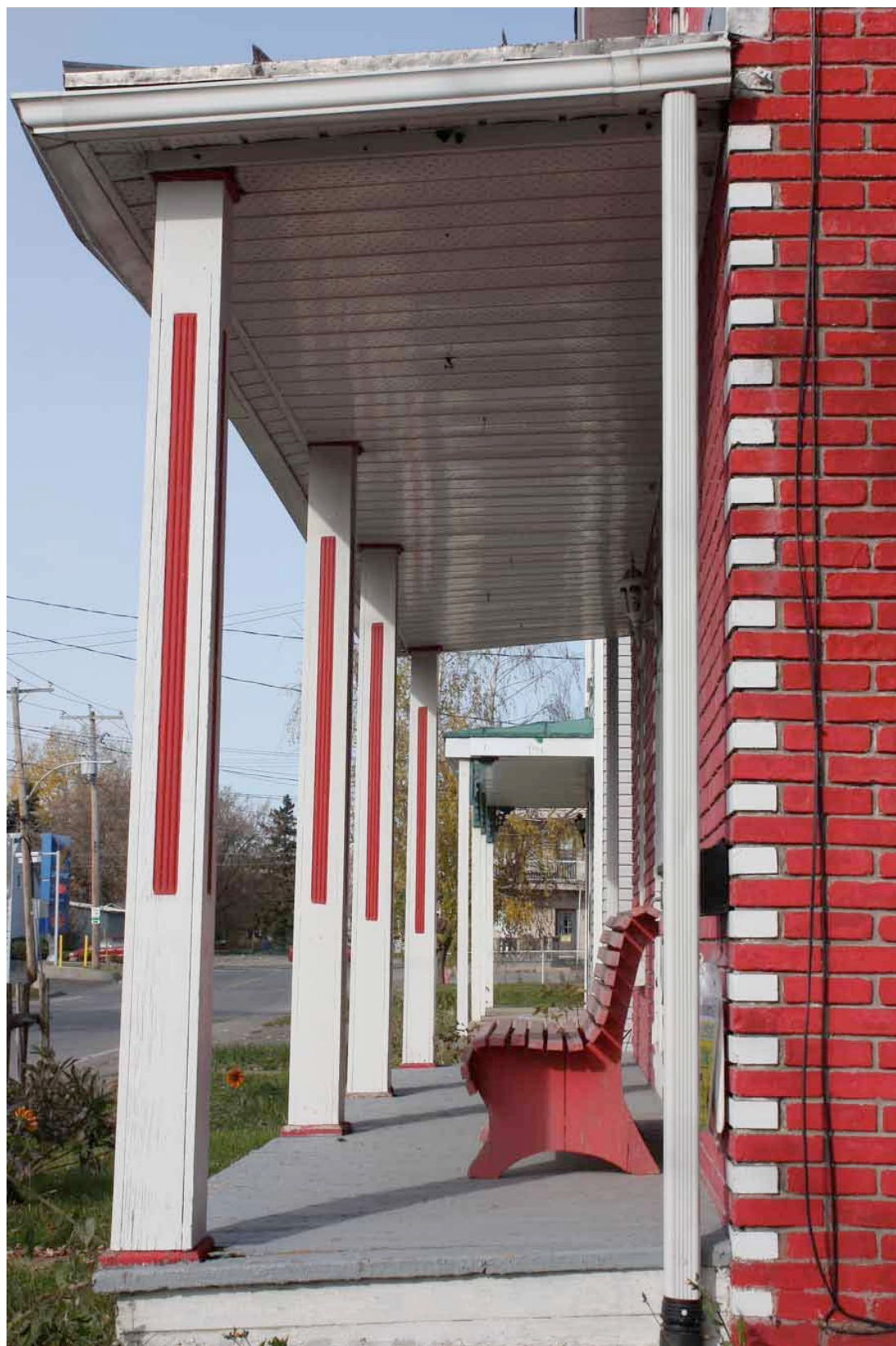
Briques traitées en bichromie et colonnes de galerie en bois au 209, 5 e Avenue. IMG_8931.jpg
