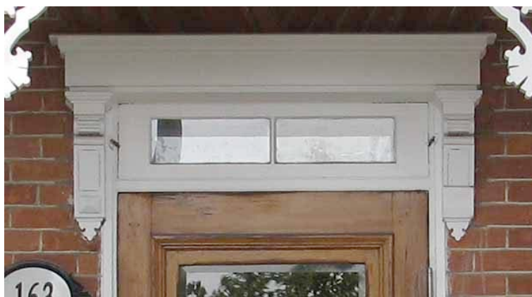
Sur la façade avant, une corniche en bois met en valeur la partie supérieure des ouvertures. À chaque extrémité, des consoles ornées encadrent l'imposte à deux carreaux. Maison des Prêtres-Chaumont. 139, boulevard Sainte-Anne. IMG_0295.jpg
