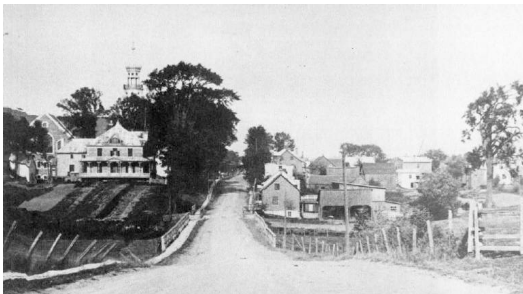
Le boulevard Sainte-Anne à la hauteur de l'église, au tout début du 20 e siècle. Cette photo donne une bonne idée de l'importance des bâtiments secondaires (à droite) construits à l'arrière des résidences. Photo parue dans : Serge Blondin, op. Cit. , p. 333.
