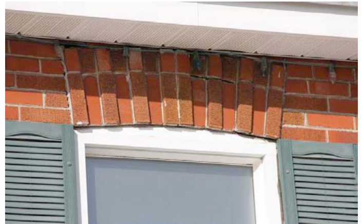
Arc surbaissé en brique rehaussé par des briques en relief. 245, 5 e Avenue. IMG_8992.jpg
