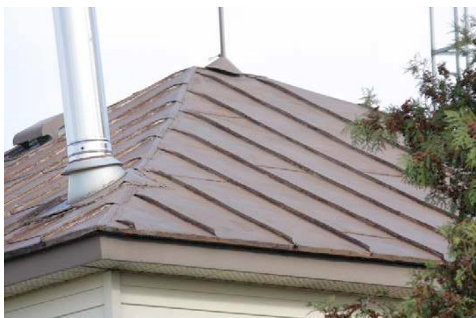
Revêtement de tôle pincée. Ce matériau traditionnel est constitué de feuilles de tôle longues et étroites dont les rivures verticales sont laissées en saillie. La tôle pincée est aussi appelée tôle agrafée . 125, rang du Trait-Carré. IMG_8182.jpg
