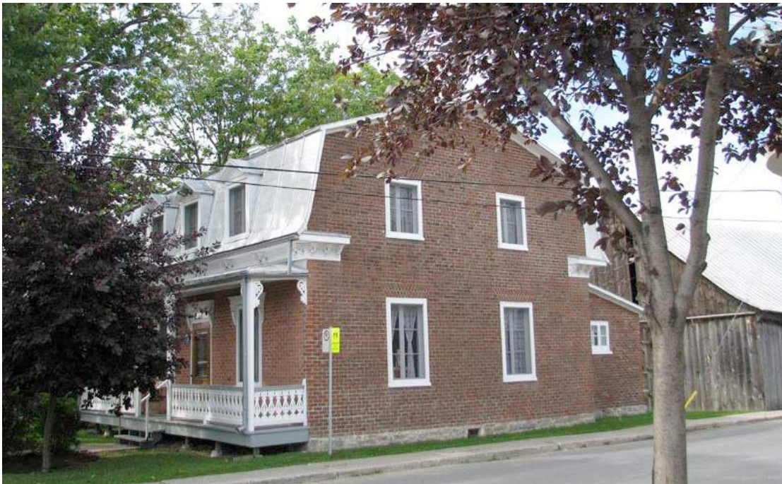
Façade avant et mur pignon est de la maison des Prêtres-Chaumont. IMG_0327.jpg
