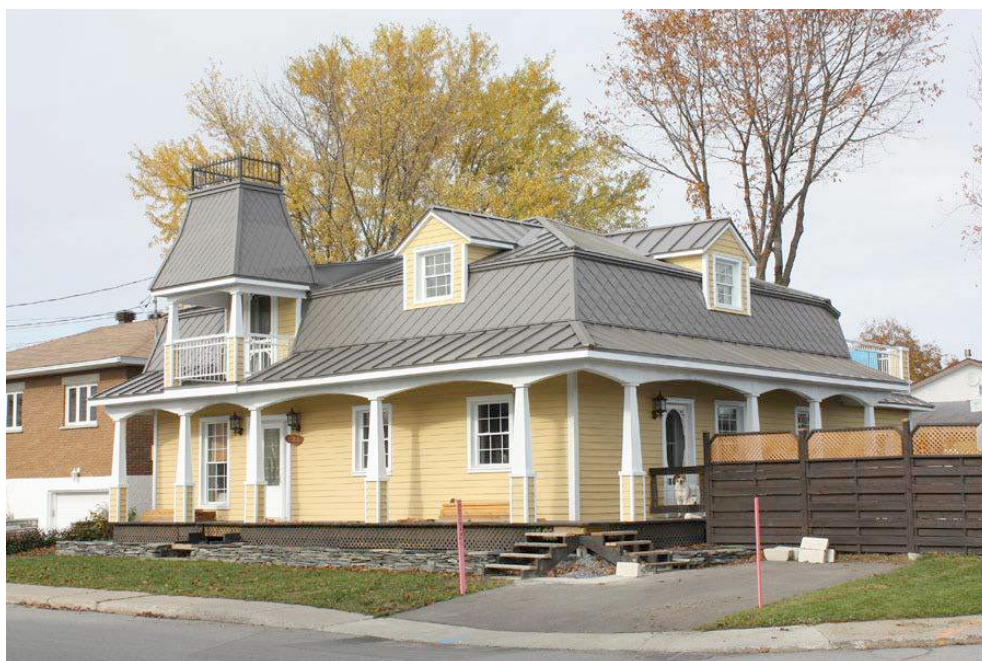
Le 221, 3 e Avenue en 2011. L'édifice a été agrandi du côté nord (où un balcon a été mis en place) et les lucarnes, déplacées sur le terrasson de la toiture. Un revêtement de planche à clin a été mis en place, ainsi qu'une galerie avec son toit. Les fenêtres à guillotine modernes s'inspirent du modèle d'origine. IMG_8674.jpg
