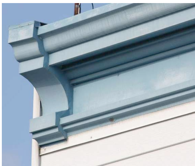
Corniche ancienne moulurée entièrement en métal, 117, rang du Trait-Carré. IMG_8207.jpg
