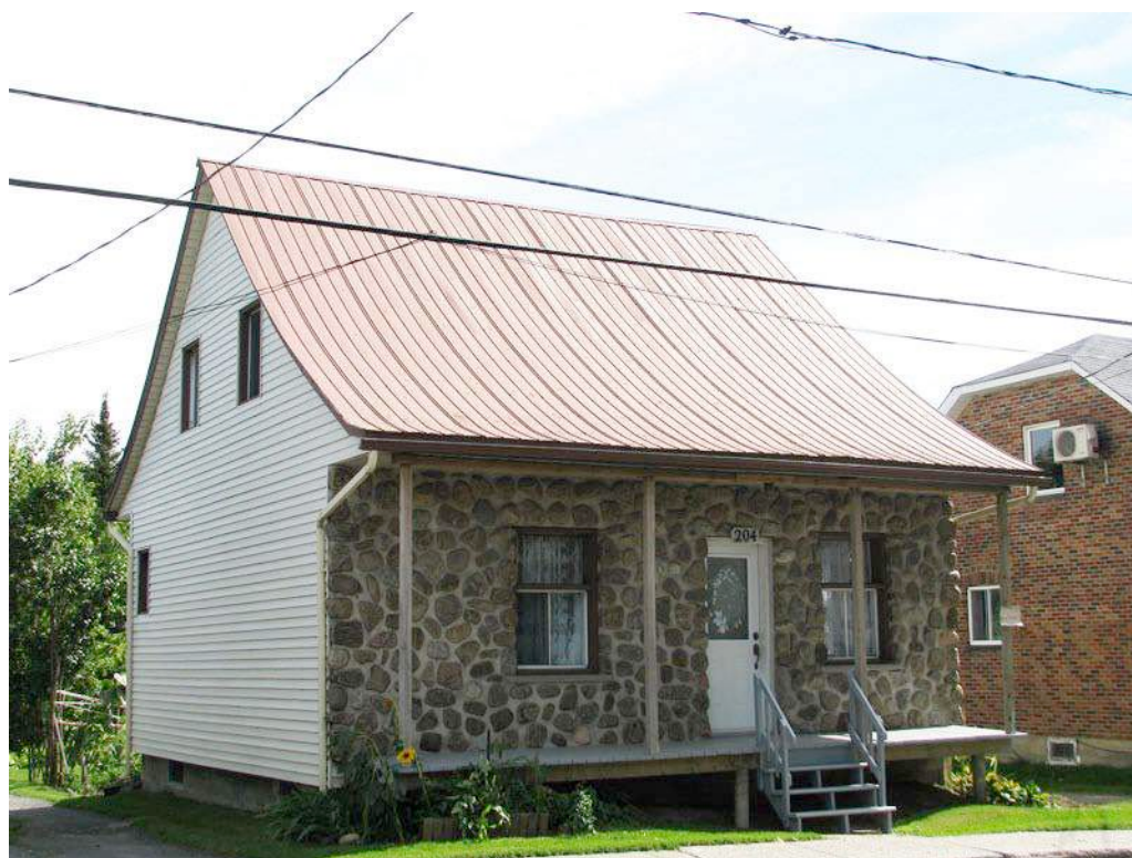
Exemple d'édifice présentant un faible état d'authenticité. 204, boulevard Sainte-Anne. Tous les revêtements anciens sont disparus, ainsi que les ouvertures, les composantes décoratives et le garde-corps. IMG_0387.jpg
