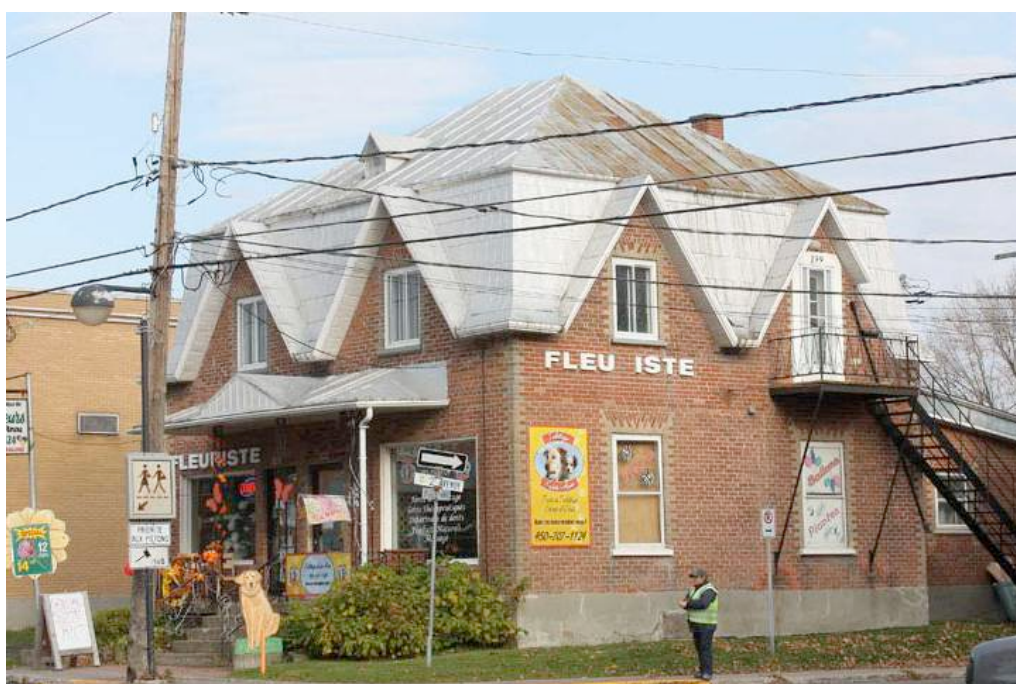
Le 142, boulevard Sainte-Anne en 2011. L'édifice a perdu sa galerie qui longeait deux murs; en outre, le format des fenêtres a été modifié en façade avant et des fenêtres à guillotine ont été mises en place à l'étage. Enfin, on a aménagé un escalier au mur latéral. La couverture de tôle a été conservée. IMG_8399.jpg
