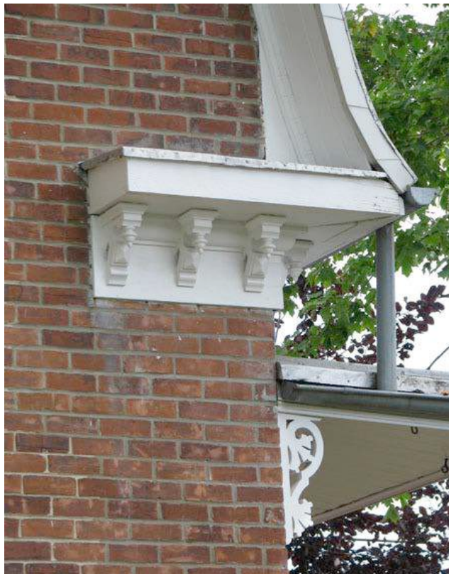
La partie inférieure du brisis de la toiture est mise en valeur par des retours de corniche ornés de modillons. À droite : des aisseliers placés sous l'auvent de la galerie. Maison des Prêtres-Chaumont. . IMG_0300.jpg
