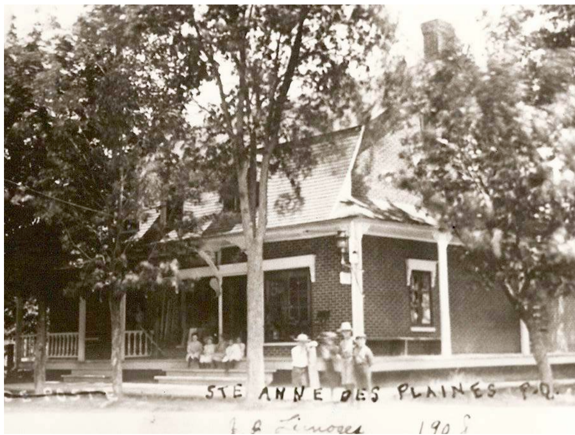
Le 168, boulevard Sainte-Anne en 1908. L'édifice abrite à l'époque le magasin général Limoges et le bureau de poste. Photo : Ville de Sainte-Anne-des-Plaines. Magasin_183_boul_Sainte-Anne_LIMOGES_Benjamin_1908.jpg
