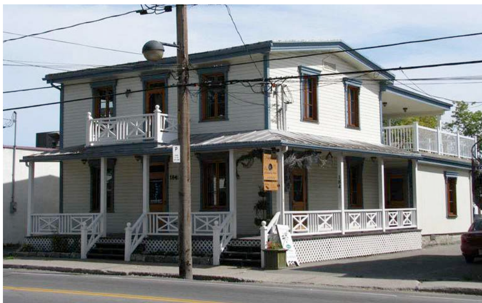
Le 184-184 B, boulevard Sainte-Anne en 2011. Outre la disparition des arbres, le corps principal de l'édifice n'a connu aucune modification depuis la prise de la photo du haut. IMG_0348.jpg
