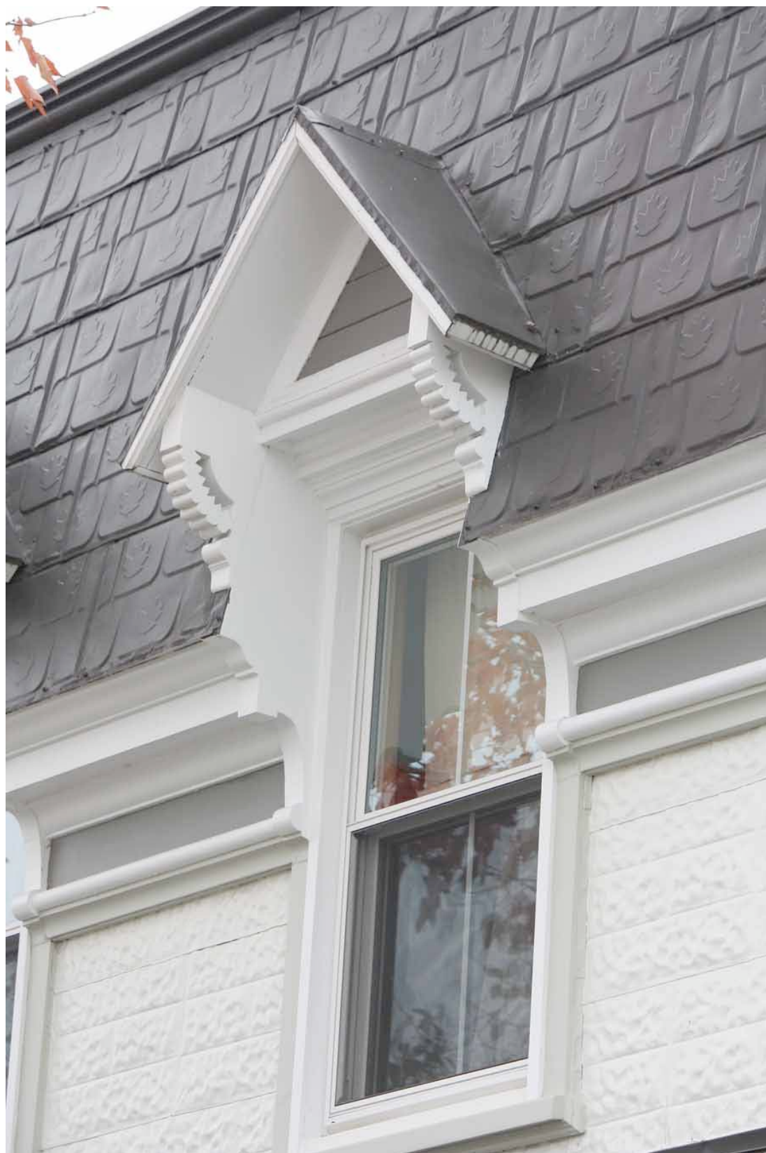
Tôle embossée et lucarne à fenêtre pendante au 228, 3 e Avenue. IMG_8642.jpg
