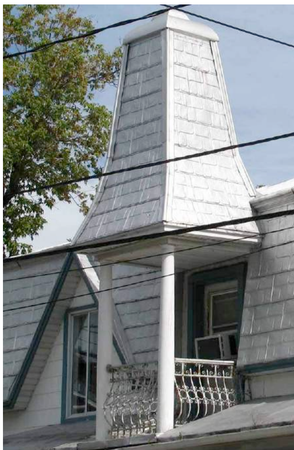
Balcon avec colonnes en bois et garde-corps en fer ornemental; la toiture est recouverte de tôle matricée. 208-210, boulevard Sainte-Anne. IMG_0399.jpg
