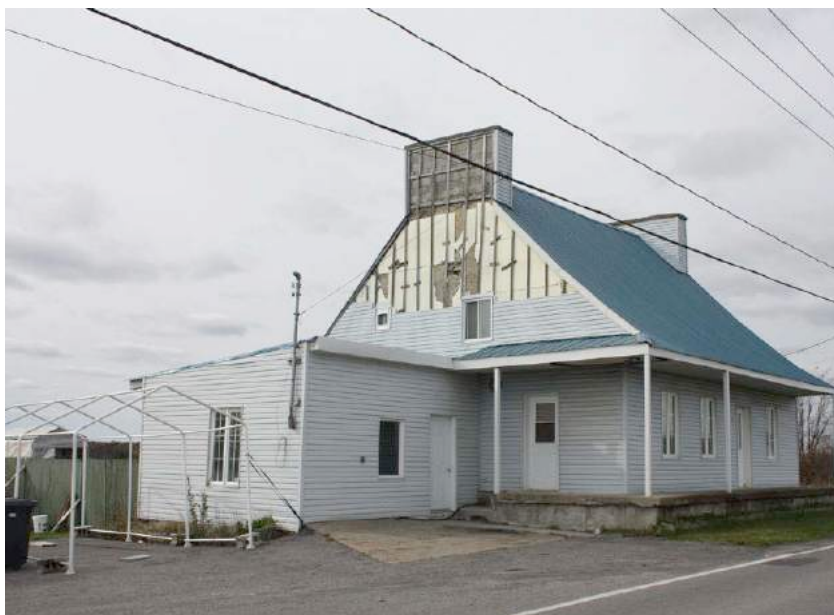
Le 742, 5 e Avenue. À en juger par sa volumétrie, la disposition asymétrique des ouvertures en façade et les larges souches de cheminée à chaque extrémité des murs pignons et en considérant sa localisation, nous croyons que l'édifice aurait été érigé à la fin du 18 e siècle. IMG_9050.jpg
