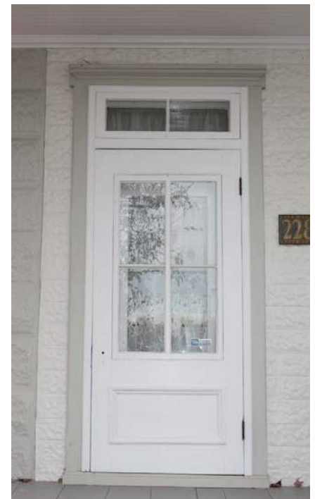
Porte traditionnelle à caisson et vitrage à carreaux, surmontée d'une imposte. 228, 3 e Avenue. IMG_8638.jpg
