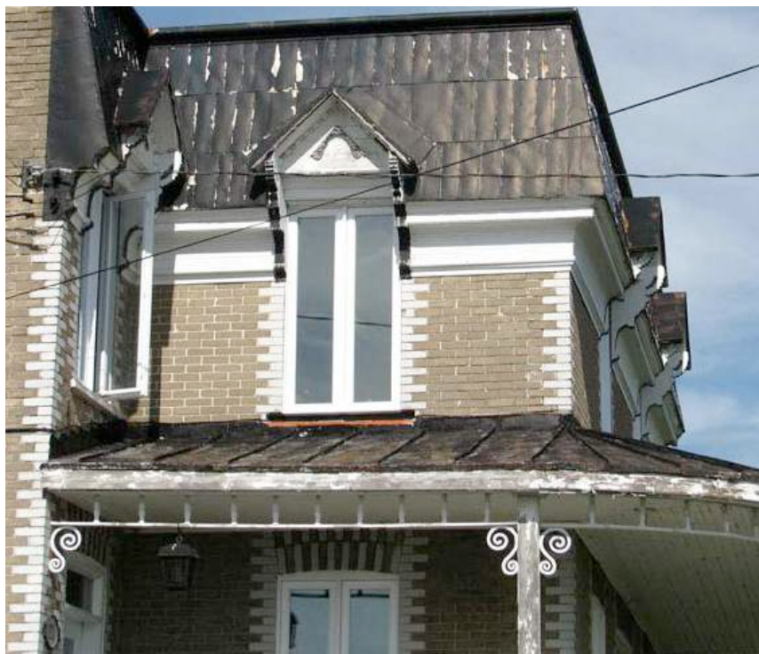
Une lucarne pendante interrompt l'avant-toit et la corniche moulurée. On retrouve le type de consoles typiquement anneplinois en bordure de la lucarne. Des aisseliers et un lambrequin mettent en valeur la bordure du toit de la galerie. 131, rang du Trait-Carré. IMG_0945.jpg
