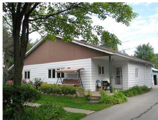
Exemple de bungalow ancien. 450, boulevard Sainte-Anne. IMG_0450.jpg
