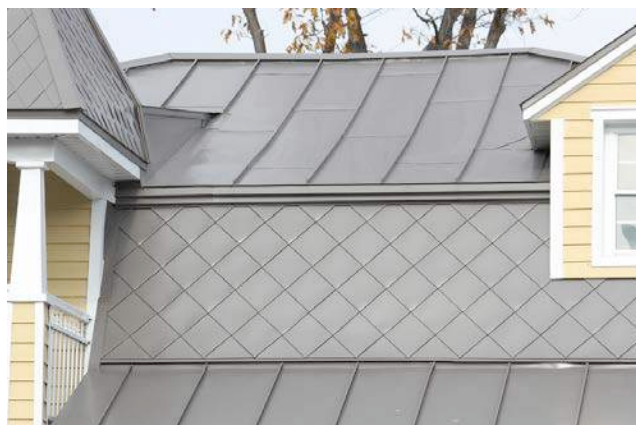
Détail de la tôle moderne des différentes toitures du 221, 3 e Avenue. Son installation respecte la technique de pose traditionnelle de la tôle agrafée (pincée) et celle de la tôle à la canadienne. IMG_8672.jpg
