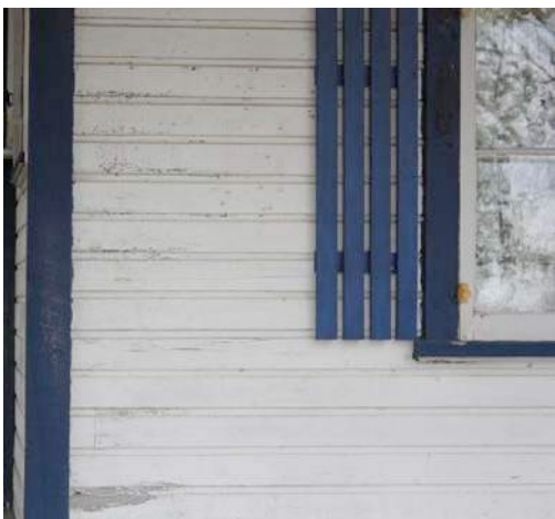
Revêtement de planche à feuillure; l'un des seuls inventoriés à Sainte-Anne-des-Plaines. 22, rang Lepage. IMG_8331.jpg
