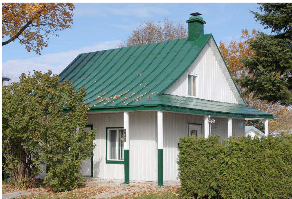
Le 239, 2 e Avenue en 2011. Depuis 1971, on a mis en place un revêtement métallique et les ouvertures anciennes sont disparues. Par contre, la tôle pincée a été conservée. IMG_8587.jpg
