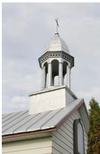
Lanternon de la chapelle du cimetière et détail du revêtement de tôle pincée. IMG_8367.jpg
