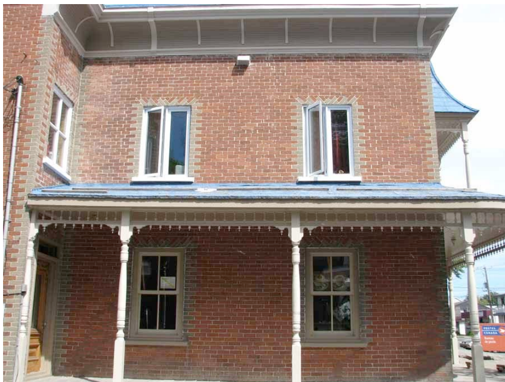
La brique des chaînes aux angles des murs et autour des ouvertures est de couleur différente de celle utilisée pour les murs. 163, boulevard Sainte-Anne. IMG_0322.jpg
