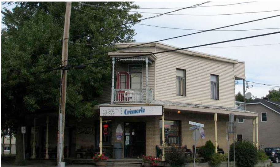
Le 220-222, boulevard Sainte-Anne en 2011. L'édifice a perdu son revêtement ancien, les consoles de la corniche, les chambranles, les planches cornières et, surtout la tourelle au-dessus du balcon. Par contre, les colonnes tournées ont été conservées, ainsi que le garde-corps à barreaux. En outre, les fenêtres modernes à imposte s'apparentent aux modèles anciens. IMG_0431.jpg
