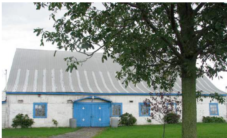
Grange-étable composée de blocs de béton, de planches verticales et de tôle profilée. 153, rang Lepage. IMG_0603.jpg
