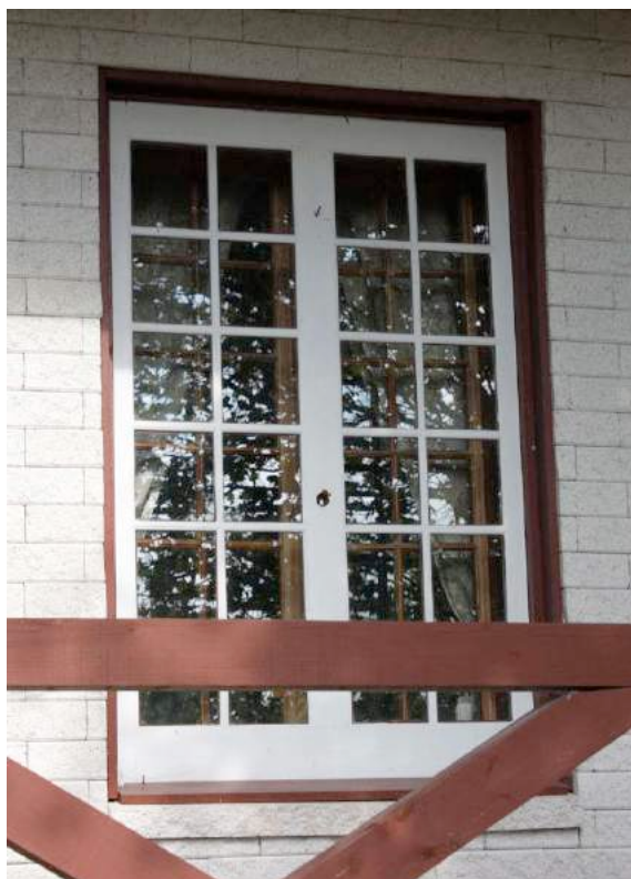
Le modèle le plus ancien de fenêtre : la fenêtre à battants à petits carreaux en bois, protégée ici par une contre-fenêtre du même type. 107, rang du Trait-Carré. IMG_8226.jpg
