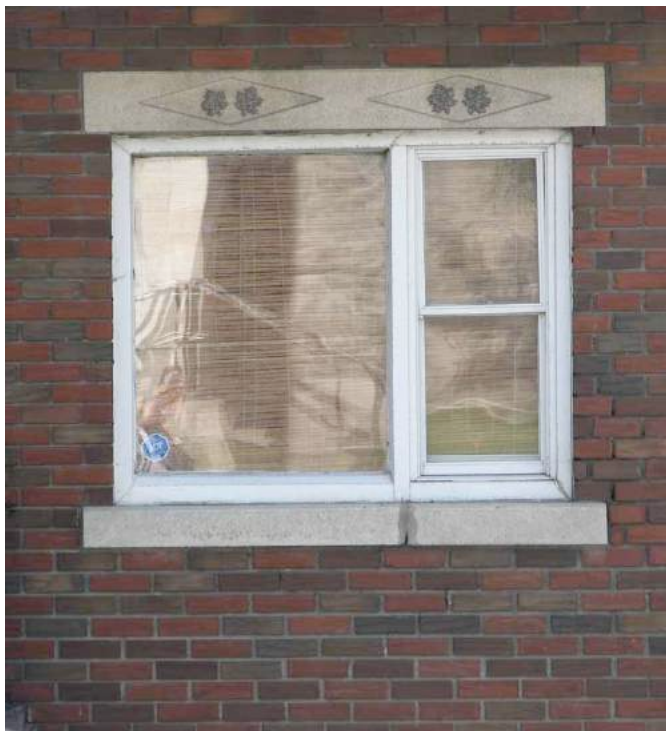
Fenêtre à battants à grands carreaux en bois et linteau en pierre de béton avec des motifs de feuille d'érable. 132, boulevard Sainte-Anne. IMG_0209.jpg
