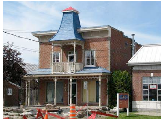
Exemple de maison éclectique. 169, boulevard Sainte-Anne. IMG_0316.jpg
