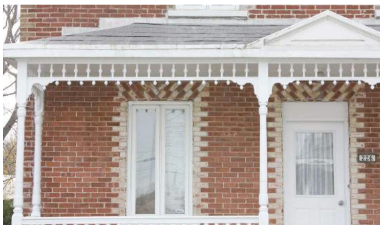
Autre édifice où le lambrequin à fuseaux a été préservé, en plus des aisseliers et des colonnes tournées. 226, 2 e Avenue. IMG_8663.jpg
