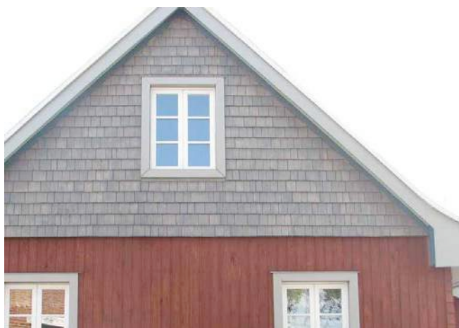
Pratiquement inexistant sur les bâtiments principaux, le bardeau de bois a été mis en place sur le pignon au 69, rang Lepage à la suite de travaux de restauration. IMG_0571.jpg
