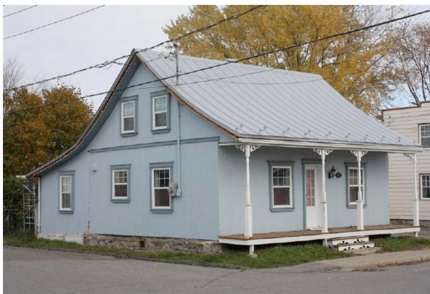
Le 215, 3 e Avenue en 2011. Un revêtement de planches unies imitant la planche emboutée traditionnelle a été mis en place, tout comme une couverture de tôle s'inspirant du modèle d'origine. Des colonnes tournées et des aisseliers ont été ajoutés. IMG_8694.jpg
