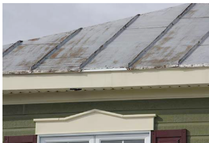
Souvent, le revêtement de tôle, ici de la tôle pincée, est le seul élément ancien qui ait été conservé, comme au 544, 5 e Avenue. IMG_9036.jpg
