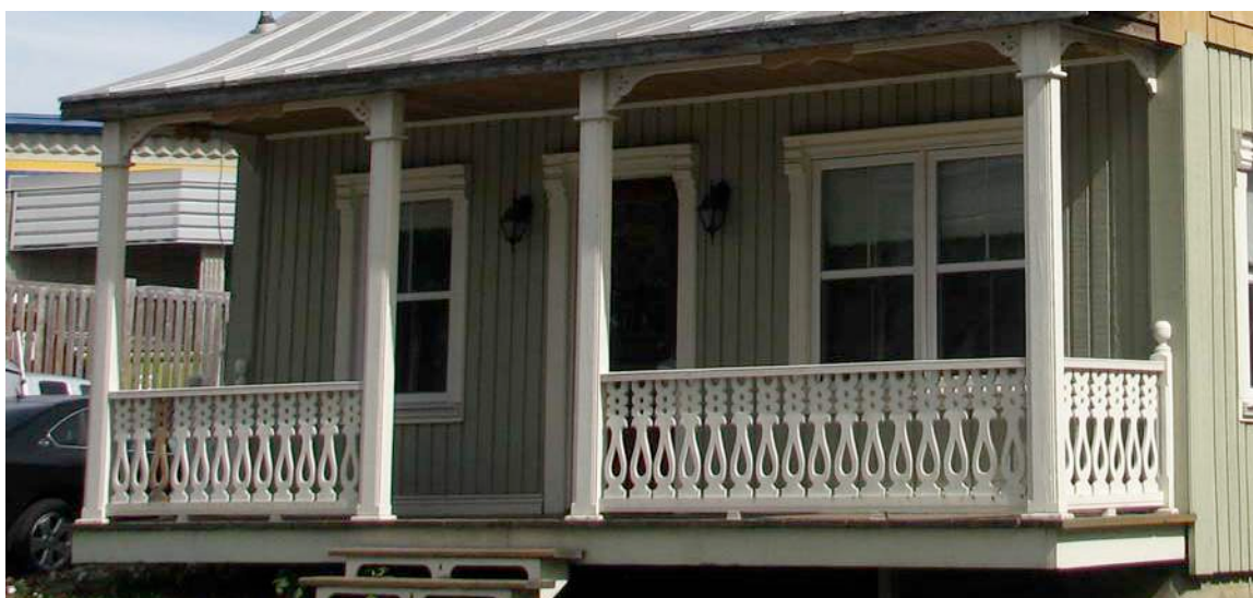
La galerie, garnie d'aisseliers et d'un lambrequin, possède en plus un garde-corps à motifs découpés. 214, boulevard Sainte-Anne. IMG_0425.jpg
