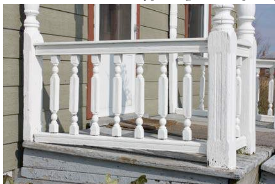
Balustrade ceinturant le perron du 91, rang du Trait-Carré. IMG_8282.jpg
