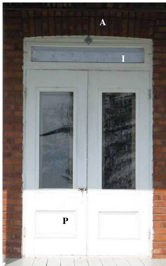
Contre-porte à panneaux (P) en bois, à double battant, avec imposte (I). Elle est surmontée d'un arc (A) en brique surbaissé. 85, rang du Trait-Carré. IMG_1022.jpg
