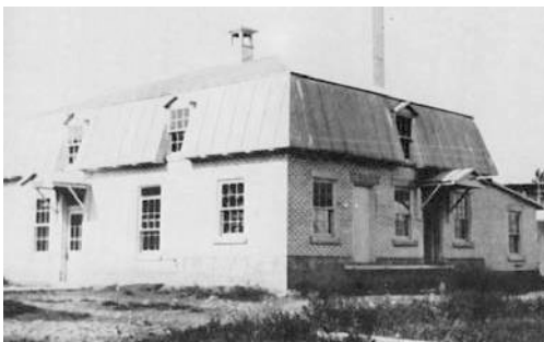
La couverture de tôle au 221, 3 e Avenue s'inspire du revêtement initial. Photo parue dans : Serge Blondin, op. cit. , 221. IMG_8670.jpg
