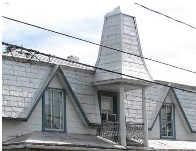
La tôle embossée caractérise le paysage architectural anneplinois. Elle est ici utilisée sur le brisis de la toiture et sur le toit pyramidal du balcon. 208-210, boulevard Sainte-Anne. IMG_0400.jpg
