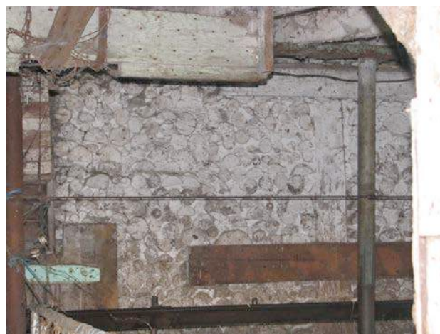
En tout ou en partie, la structure de la grange-étable est en billes sur billes. IMG_0602.jpg
