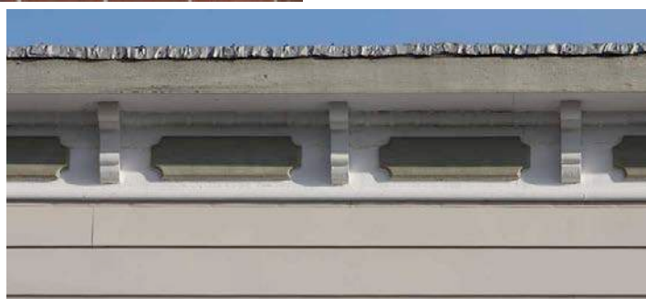
Autre modèle de corniche à consoles, au 224-226, 3 e Avenue, où la frise est ornée de panneaux moulurés et découpés. IMG_8653.jpg
