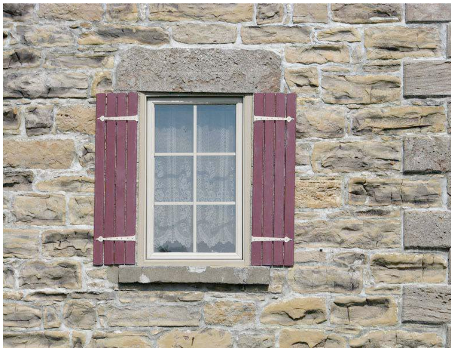
Mur de moellons usés par les intempéries. Un massif linteau de calcaire surmonte la fenêtre alors qu'une chaîne d'angle du même matériau marque l'extrémité des murs. 49, rang du Trait-Carré. IMG_0916.jpg
