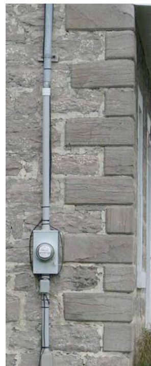
Chaîne d'angle en pierre calcaire. Les pierres de la chaîne sont taillées alors que celles du mur sont des moellons à peine dressés. 447, rang Lepage. IMG_0699.jpg
