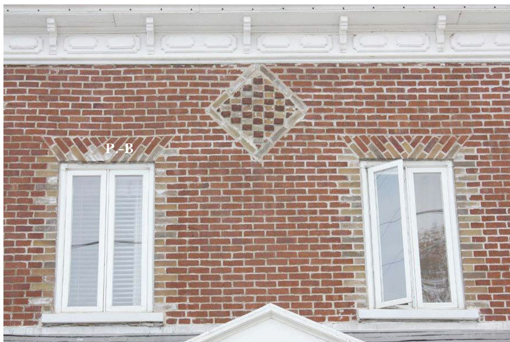
Autre exemple de façade faisant usage de brique de deux couleurs, le 224-226, 3 e Avenue. Notez les plates-bandes (P.-B) dont les briques sont à 45 degrés. IMG_8664.jpg
