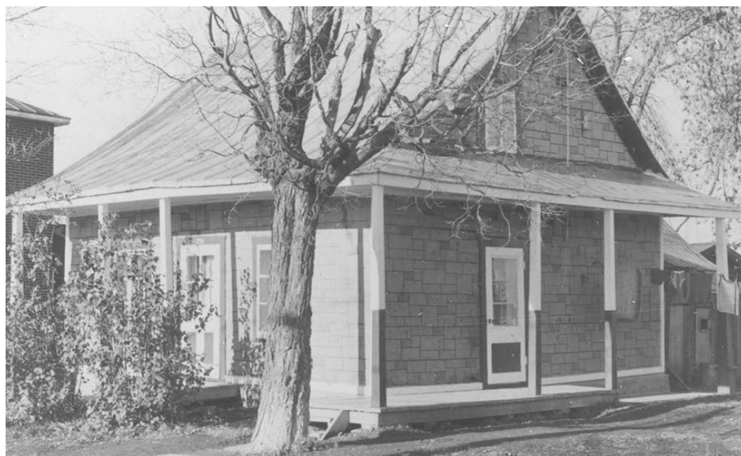
Le 239, 2 e Avenue en 1971. Les murs de l'édifice sont alors revêtus de bardeau d'asphalte; on retrouve encore les fenêtres à battants à grands carreaux et les portes à panneau et vitrage à carreaux. Une tôle, probablement pincée, recouvre la toiture. Photo parue dans : Histart inc., Inventaire des bâtiments anciens , 1971. 239, 2e avenue Photo 007.jpg
