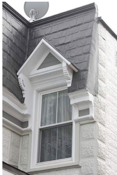
Autre fenêtre à lucarne pendante où les consoles sont identiques à celles de la photo du haut. 228, 2 e Avenue. IMG_8644.jpg
