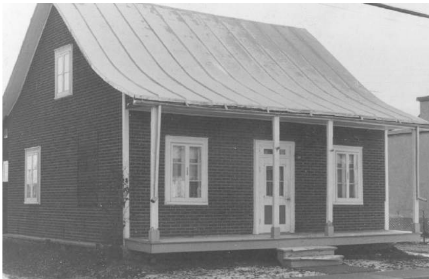
Le 215, 3 e Avenue en 1971. L'édifice est alors revêtu de bardeau d'asphalte et possède encore ses fenêtres à battants à grands carreaux ainsi qu'une porte à panneaux et vitrage, surmontée d'une imposte. Un toit de tôle pincée ou à baguettes est en place. Photo parue dans : Histart inc., Inventaire des bâtiments anciens , 1971. 215, 3 e avenue-1 Photo 009.jpg
