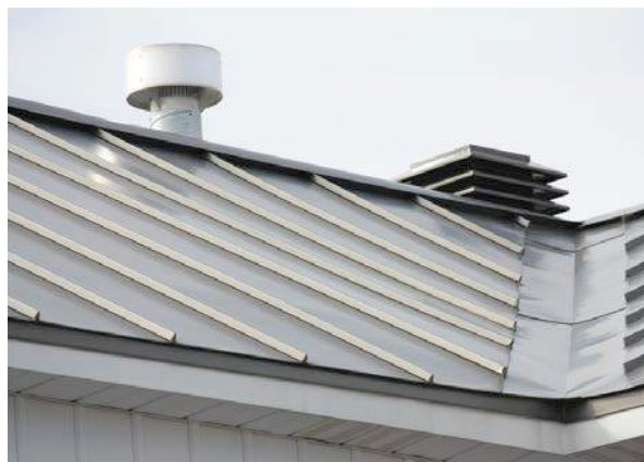
Détail de la couverture en tôle pincée du 226-230, 2 e Avenue. Le procédé respecte largement les façons de faire traditionnelles. IMG_8566.jpg
