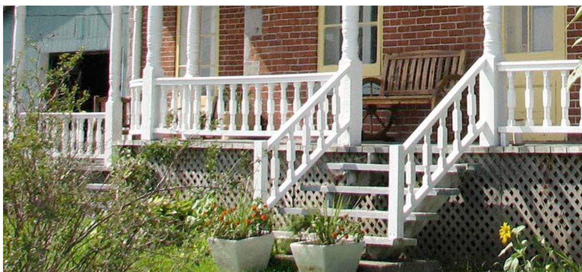
Une des rares galeries de Sainte-Anne-des-Plaines dont le garde-corps est constitué de balustres. Ce type de garde-corps s'appelle aussi balustrade. 39, rang du Trait-Carré. IMG_0895.jpg
