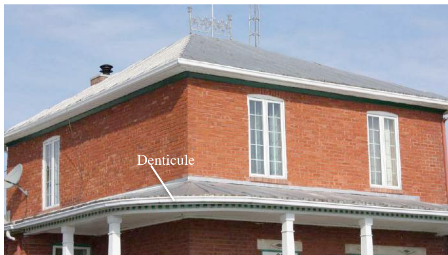
Galerie avec tous ses éléments d'origine en bois : colonnes, toit et corniche à denticules, ces éléments moulurés en bois en bordure du toit de la galerie. 93, rang du Trait-Carré. IMG_8274.jpg
