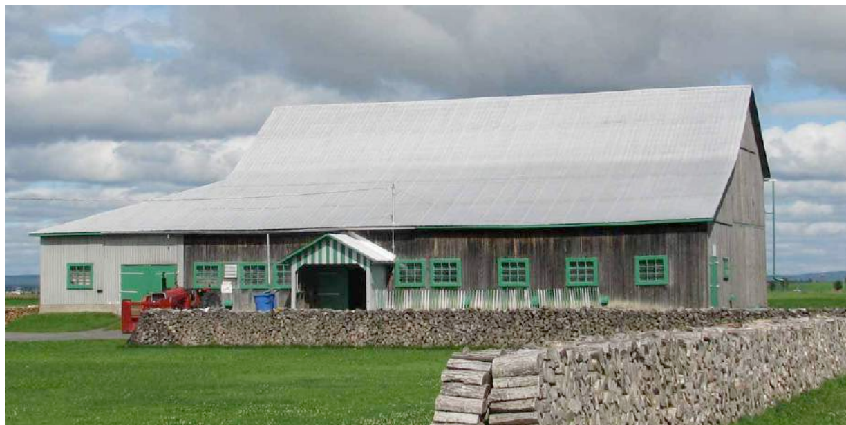
Grange-étable ayant conservé ses caractéristiques architecturales d'origine : revêtement de planches verticales, fenêtres à petits carreaux et portes à battants. 121, rang Lepage. IMG_0582.jpg
