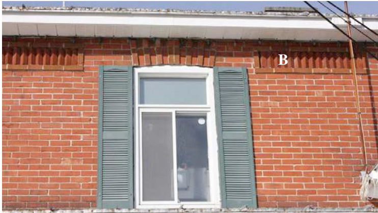
La partie supérieure du mur comporte des bandeaux (B) décoratifs en brique. 245, 5 e Avenue. IMG_8988.jpg
