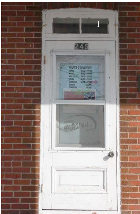
Autre modèle de porte à panneau et vitrage. La partie supérieure de l'imposte (I) épousé une forme en arc surbaissé. 245, 5 e Avenue. IMG_8981.jpg
