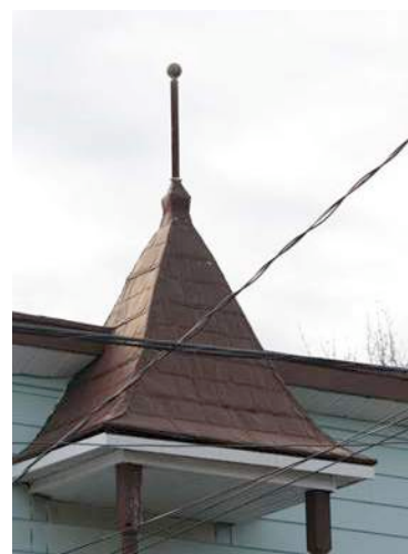
Revêtement de tôle embossée sur le toit du balcon du 230, 3 e Avenue. IMG_8626.jpg
