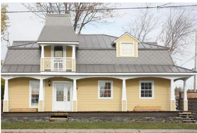
Couverture de tôle en différentes sections récemment installée au 221, 3 e Avenue. IMG_8670.jpg
