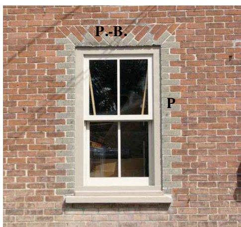
Mur de brique, avec piédroit (P) et plate-bande (P.-B.), dont la bichromie est remarquable. 169, boulevard Sainte-Anne. IMG_0324.jpg
