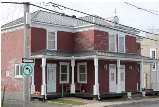
Couverture en tôle pincée récemment mise en place au 226-230, 2 e Avenue. IMG_8562.jpg
