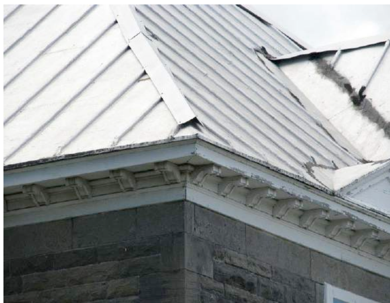
Tôle à baguettes recouvrant le toit et consoles en bois en bordure de l'avant-toit. IMG_0175.jpg
