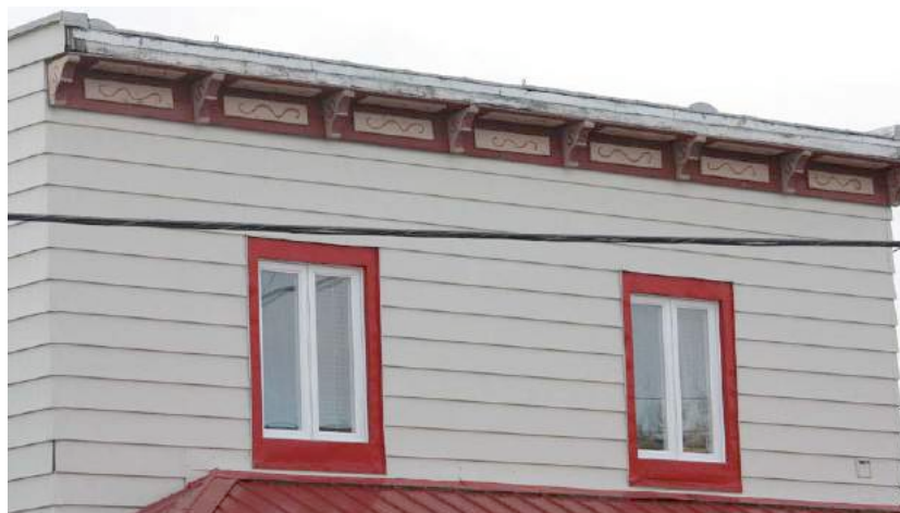
Au 214, 3 e Avenue, une corniche dont la frise est décorée avec des appliques et des consoles. La corniche est le seul élément ancien qui a été conservé sur cet édifice. IMG_8704.jpg
