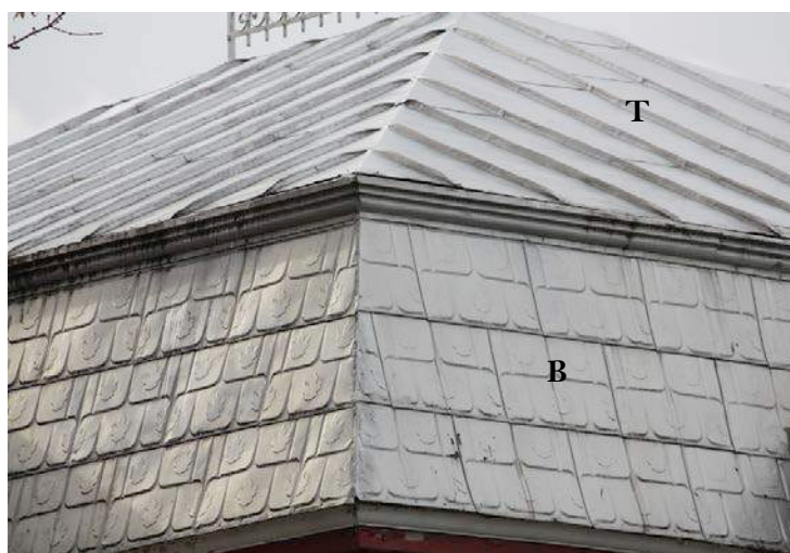
Le terrasson (T), la partie supérieure de la toiture, est recouvert de tôle pincée alors que le brisis (B), la partie la plus visible du toit, est revêtu d'une tôle embossée à motif de feuille d'érable. 203, boulevard Sainte-Anne. IMG_9105.jpg
