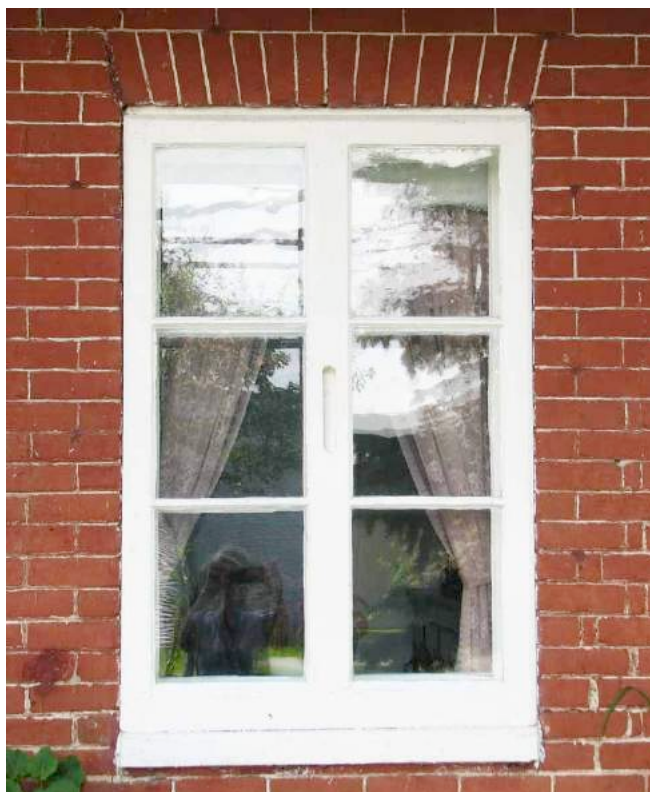
La fenêtre à battants à grands carreaux à contre-fenêtre extérieure. Le modèle le plus usuel sur les édifices du 19 e siècle. 81, chemin de La Plaine. IMG_0554.jpg
