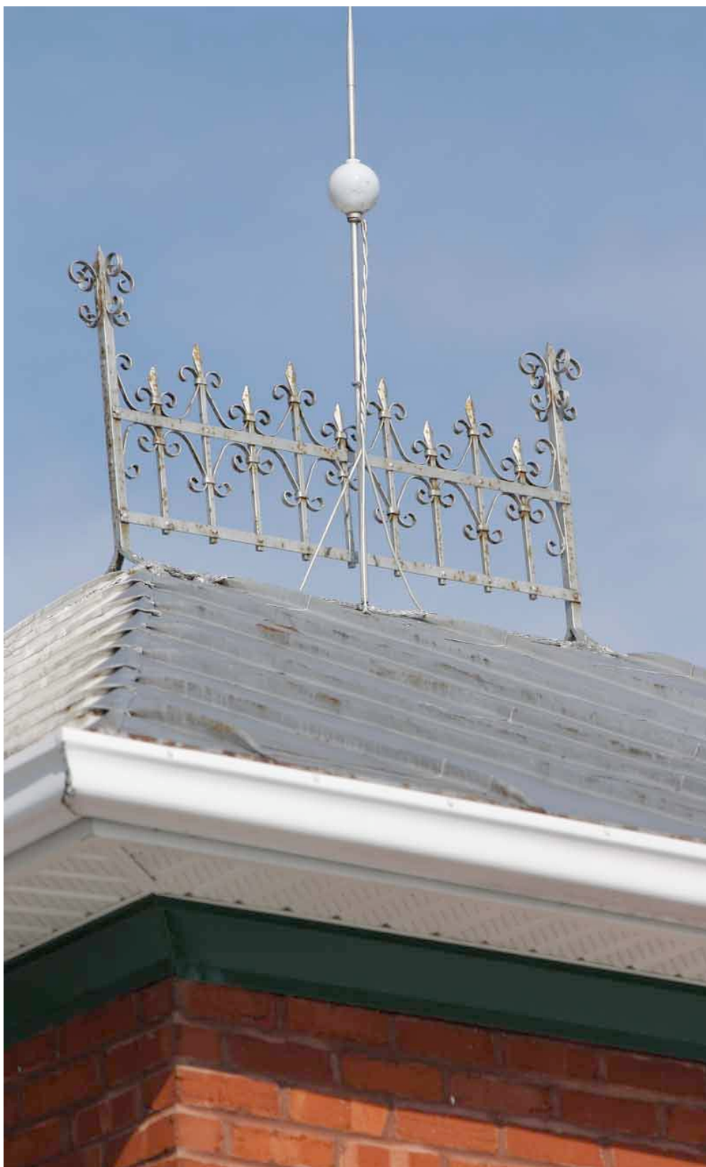
Balustrade de couronnement au sommet du toit du 93, rang du Trait-Carré. IMG_8260.jpg
