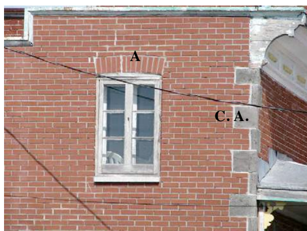
Mur de brique; à droite, une chaîne d'angle (C. A.) en pierre. Un arc surbaissé (A) en brique surmonte la fenêtre. 49, rang du Trait-Carré. IMG_0900.jpg
