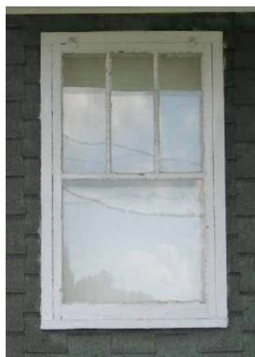
Fenêtre à guillotine dont la partie supérieure est à petits-bois. 121, rang Lepage. IMG_8238.jpg
