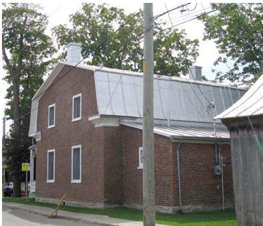
Corps secondaire à l'arrière de la maison des Prêtres-Chaumont. IMG_0301.jpg
