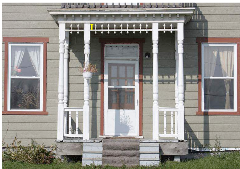
Perron ayant conservé son garde-corps à balustres, ses colonnes tournées et, au sommet, un lambrequin (L). 91, rang du Trait-Carré. IMG_8282.jpg
