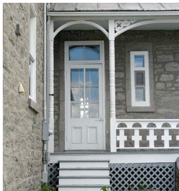
Porte à panneaux et vitrage, à imposte encadrée de colonnes tournées. IMG_0180.jpg
