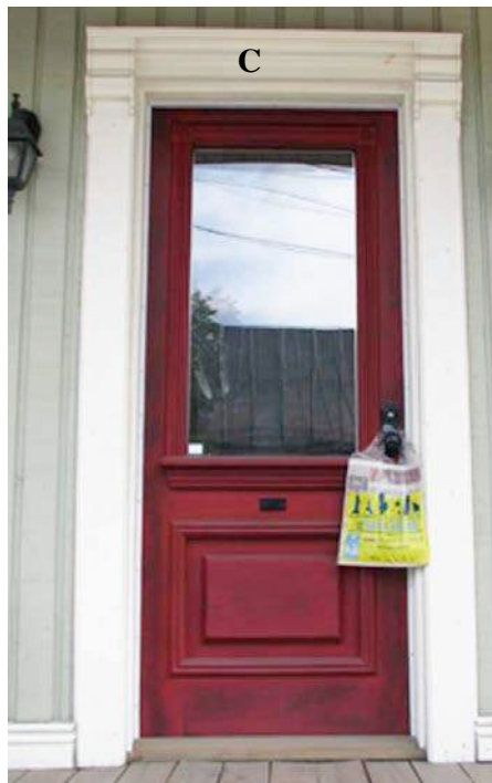
Cette porte à panneau en bois a été refaite selon un modèle ancien. Elle est par ailleurs encadrée d'un chambranle avec corniche (C). 214, boulevard Sainte-Anne. IMG_0427.jpg
