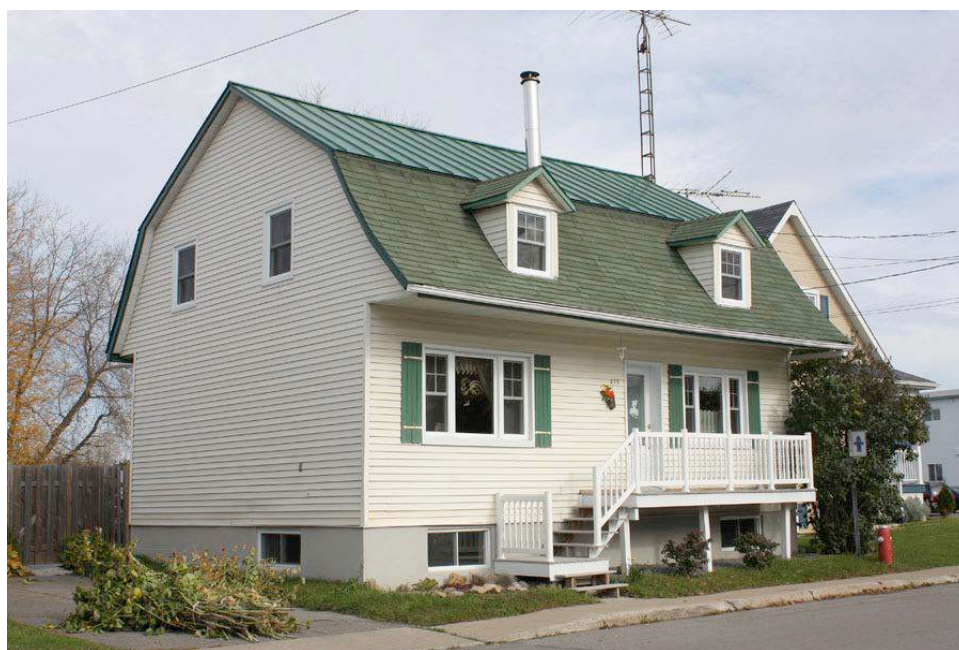
Le 235, 3 e Avenue en 2011. Les principales modifications concernent la disparition de fenêtres au mur pignon gauche et le changement du format et du modèle de fenêtre. Les colonnes sous l'avant-toit sont disparues. Par contre, la couverture en tôle moderne qui recouvre le terrasson reprend la technique de pose traditionnelle de la tôle agrafée (pincée). IMG_8610.jpg
