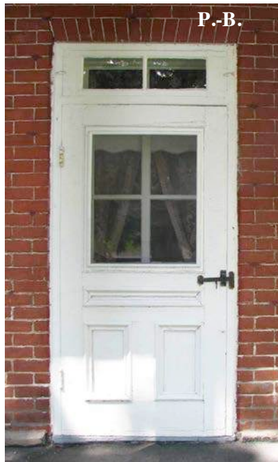
Contre-porte à panneaux en bois, avec imposte, surmontée d'une plate-bande (P.-B.) en brique. 84, chemin de La Plaine. IMG_0555.jpg
