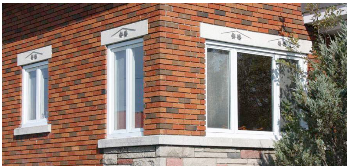
Fenêtres modernes surmontées d'un linteau en pierre de béton avec des motifs de feuille d'érable. 99, rang du Trait-Carré. IMG_8244.jpg
