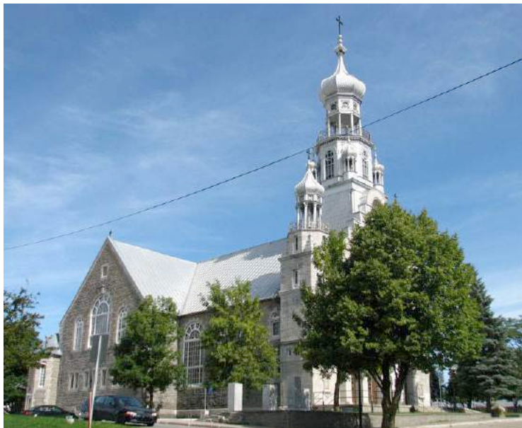
Mur gouttereau ouest et façade principale. IMG_0229.jpg
