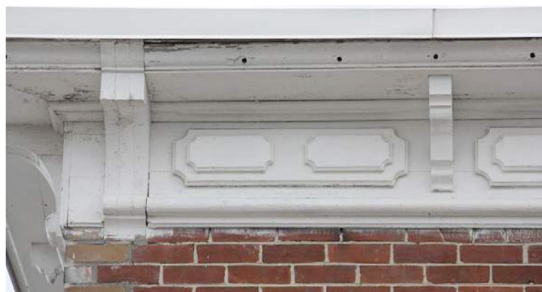
Autre modèle de corniche à consoles, au 224-226, 3 e Avenue, où la frise est ornée de panneaux moulurés et découpés. IMG_8653.jpg
