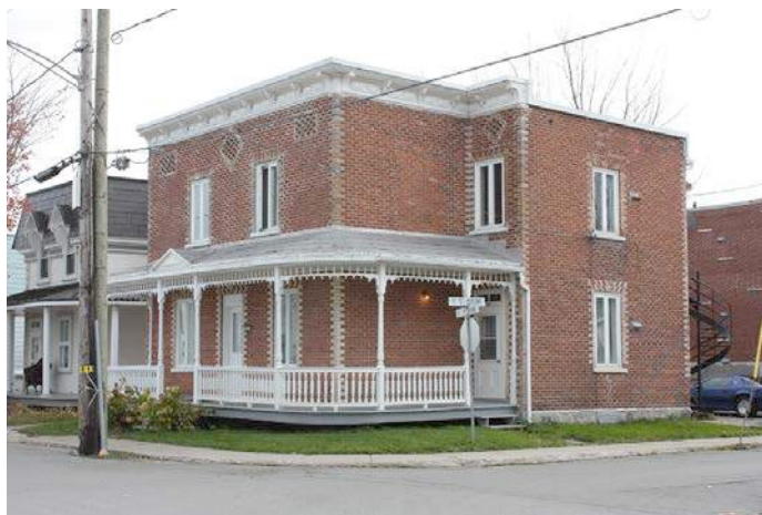
Exemple de maison cubique, du sous-type au toit plat. 224-226, 3 e Avenue. IMG_8651.jpg
