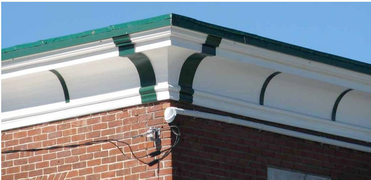
Corniche moulurée. Travail conjoint du menuisier et du ferblantier. 69, boulevard Sainte-Anne. IMG_0033.jpg
