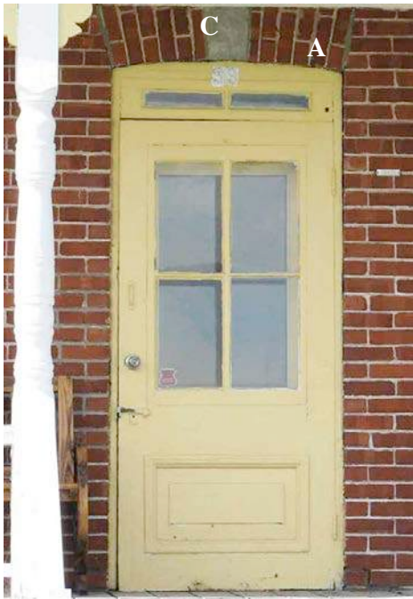
Contre-porte à panneau en bois, avec imposte, surmontée d'un arc (A) en brique avec clef (C). 39, rang du Trait-Carré. IMG_0903.jpg
