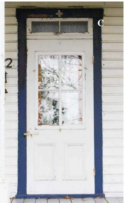
Contre-porte à panneaux en bois, avec imposte, encadrée d'un chambranle (C) en bois. 22, rang Lepage. IMG_8328.jpg
