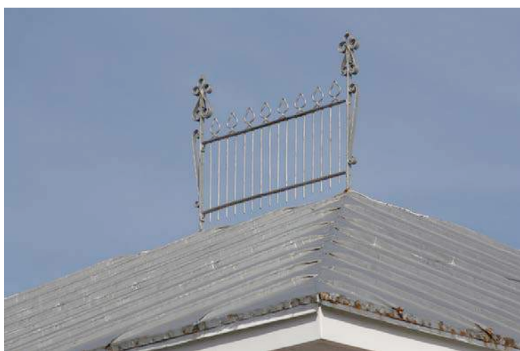
Balustrade de couronnement en fer ornemental placée au sommet d'une toiture à quatre versants, recouverte de tôle pincée. 245, 5 e Avenue. IMG_8983.jpg
