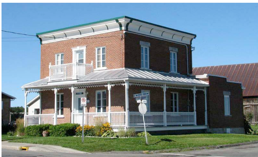
Le 69, boulevard Sainte-Anne en 2011. L'édifice a connu peu de modifications depuis sa construction. Si des fenêtres à manivelle sont désormais en place, leur modèle s'inspire de celui qu'on retrouvait à l'origine. Il en est ainsi pour les portes et les garde-corps. Cependant, la corniche moulurée, les aisseliers, le lambrequin et le toit de tôle à baguettes sur la galerie ont été conservés. IMG_0034.jpg
