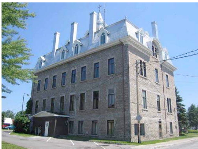
Façade arrière et mur latéral ouest de l'ancien couvent de Sainte- Anne-des-Plaines. © Ministère de la Culture, des Communications et de la Condition féminine, Jean-François Rodrigue, 2005
