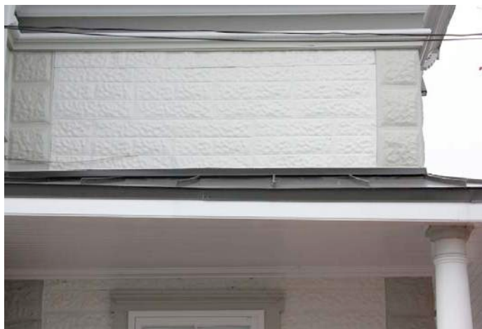
Revêtement de tôle embossée. Aussi appelé tôle matricée, il s'agit d'un matériau traditionnel de revêtement de mur ou de toit sur lequel des motifs ont été marqués à l'aide d'une matrice. 228, 3 e Avenue. IMG_8649.jpg
