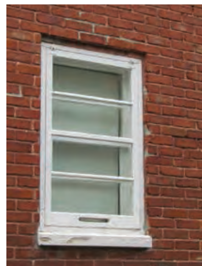
Contre-fenêtre à barreaux horizontaux devant une fenêtre à guillotine. 2-4, rue Tassé, Sainte-Thérèse.
