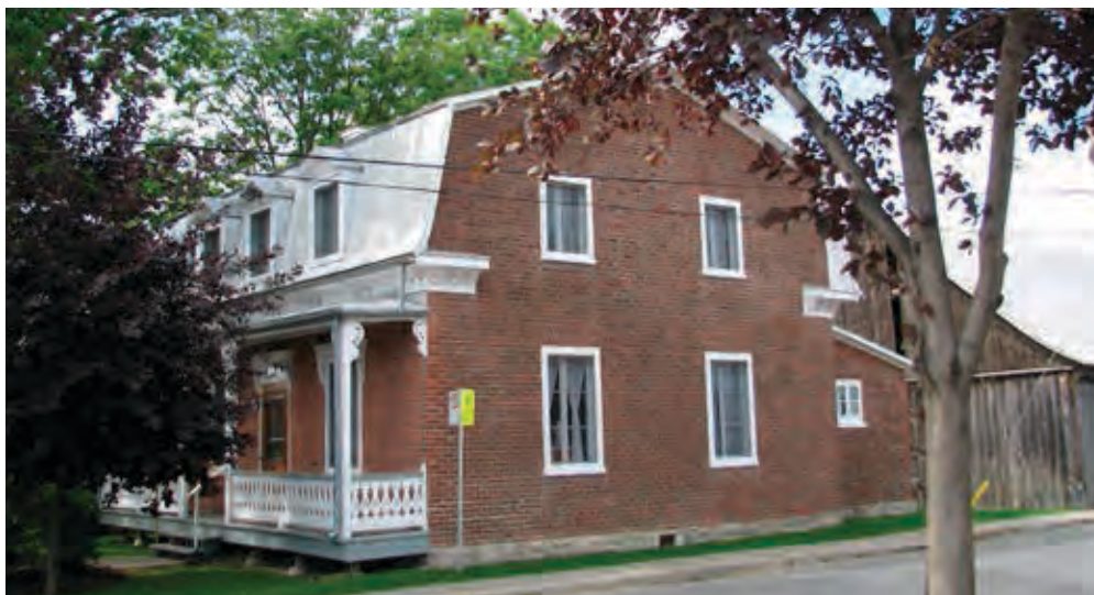
Façade avant et mur pignon est de la maison des Prêtres-Chaumont, un immeuble patrimonial classé, 163, boulevard Sainte-Anne, Sainte-Anne-des-Plaines.
