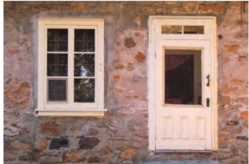
Fenêtre à battants à six grands carreaux et porte en bois à menuiserie d'assemblage. Maison Labelle, 200, chemin du Bas-de-Sainte-Thérèse, Blainville.
