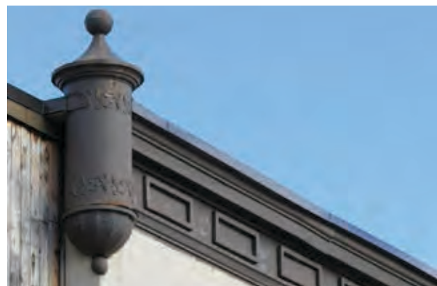
Un modèle tout à fait exceptionnel d'urne (à l'extrême gauche) en tôle délimitant une frise également en tôle, ornée d'appliques moulurées. 41, rue Blainville Ouest, Sainte-Thérèse.
