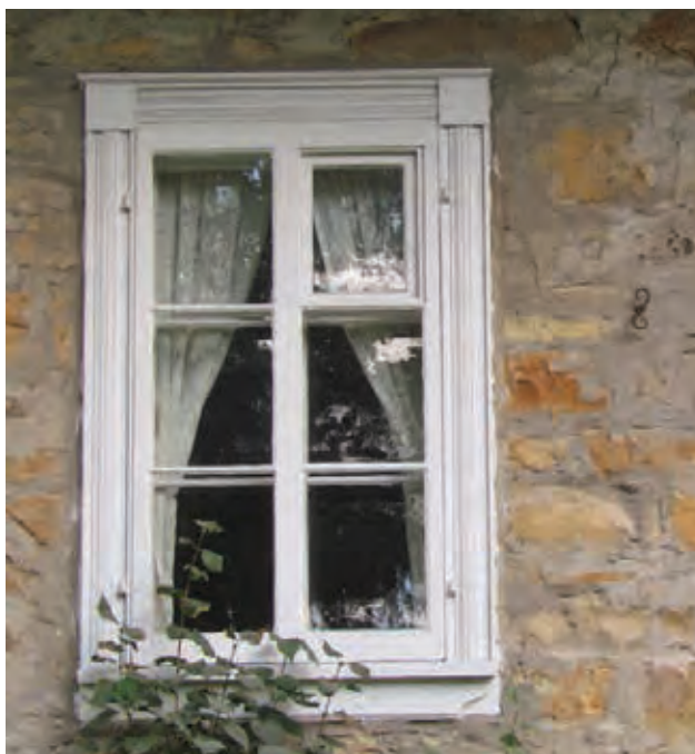
Fenêtre à battants à grands carreaux, l'un des modèles les plus usuels en architecture ancienne. Maison Williams-Miller, 475, rue Émile-Nelligan, Boisbriand.
