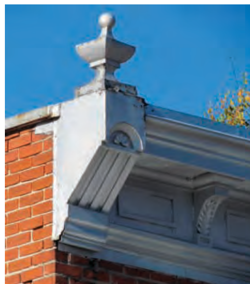
Console avec urne, et extrémité d'une corniche à consoles; tous ces éléments sont en tôle sur une structure de bois. 17-19, rue Saint-Lambert, Sainte-Thérèse.
