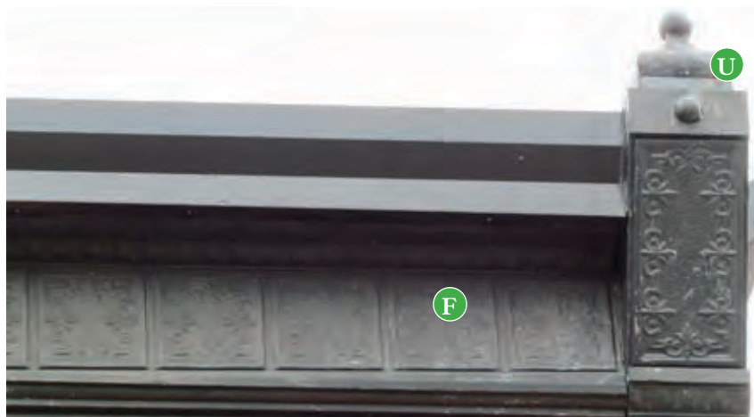
Frise (F) dotée de rares et fins motifs en tôle embossée. La corniche est surmontée d'une urne (U) en tôle. 10-16, rue Saint-Joseph, Sainte-Thérèse.
