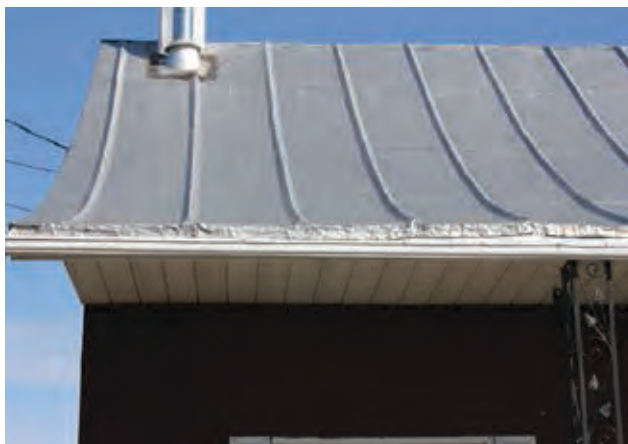
Tôle à baguettes. 205, 2 e Avenue, Sainte-Anne-des-Plaines.
