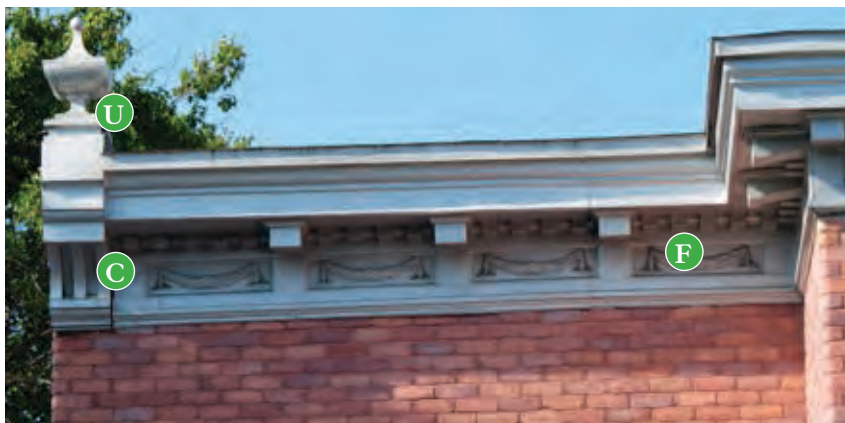
Imposante corniche en tôle; on retrouve sur la frise une urne (U), d'imposantes consoles (C) et des festons de guirlandes de fleurs (F). Vraiment magnifique! À voir au 6-10, rue Turgeon, Sainte-Thérèse.
