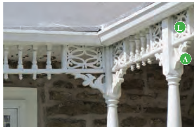
Fort beaux modèles de lambrequins (L) et d'aiseliers (A). Ils sont soit d'origine, soit restaurés selon un modèle ancien. 39-41, chemin de la Côte Sud, Boisbriand.
