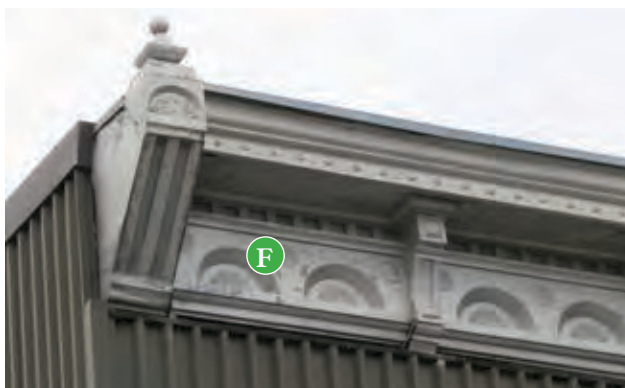
Console surmontée d'une urne et d'une corniche en tôle avec frise (F) à motifs incrustés. Hôtel Blainville, 27-29, rue Blainville Ouest, Sainte-Thérèse.
