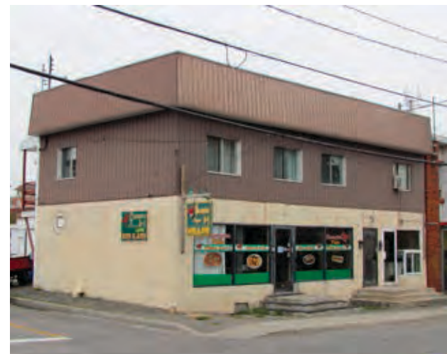
La corniche de cet édifice de Sainte-Thérèse a été masquée, tous les revêtements, les ouvertures et les composantes décoratives sont disparus.
