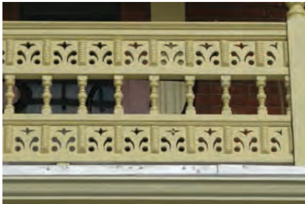
Garde-corps plein à motifs circulaires ajourés et à balustres (B) appliqués, un modèle vraiment très rare. Maison du docteur Avila Larose, 10-12, rue Saint-Charles, Sainte-Thérèse.
