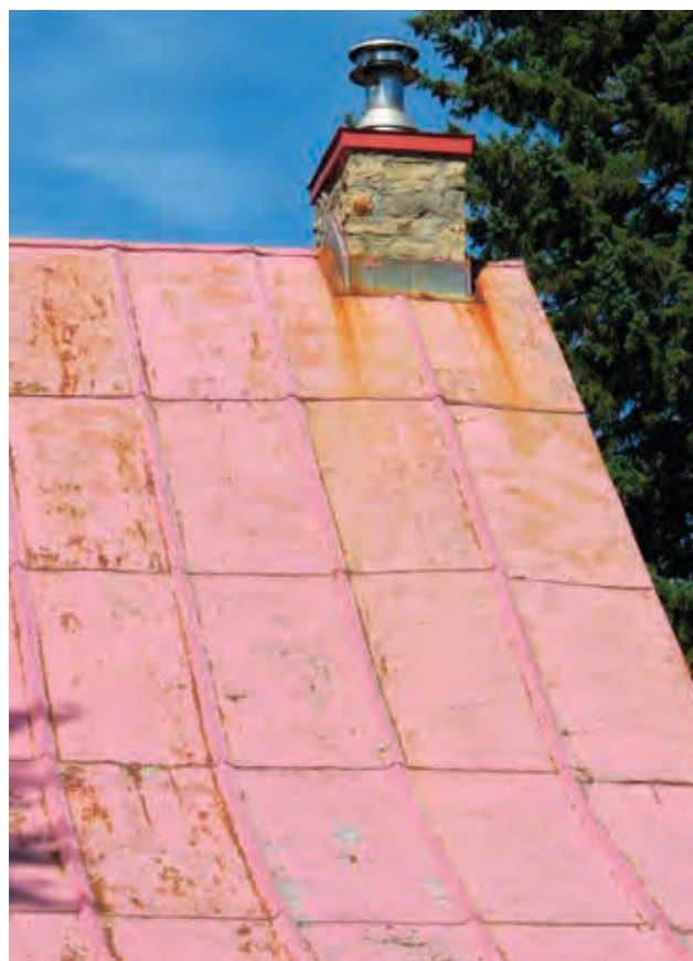
Détail d'un revêtement de tôle à baguettes. 118, rue Blainville Ouest, Sainte- Thérèse.
