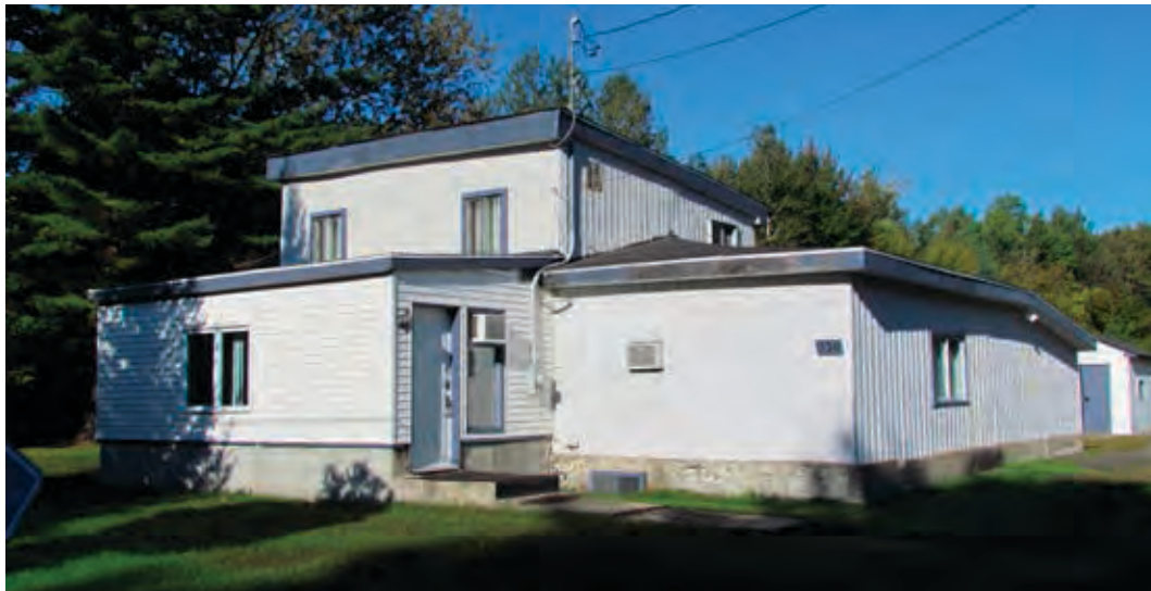
En raison de l'ajout de corps secondaires, le volume d'origine demeure difficilement perceptible sur cet édifice de Blainville.
