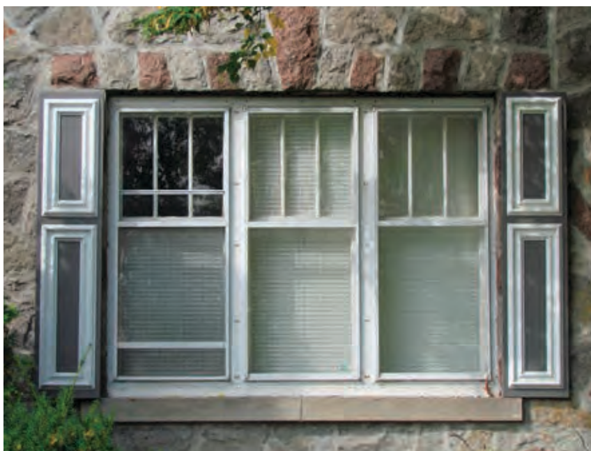
Fenêtre triplet à guillotines à petits-bois. 309, boulevard Adolphe-Chapleau, Bois-des-Filion.
